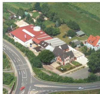
Das Betriebsgelände in Brinkum
